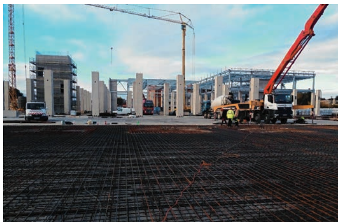
Az alaplemez armatúrája, vagyis a betonacél szerkezet
