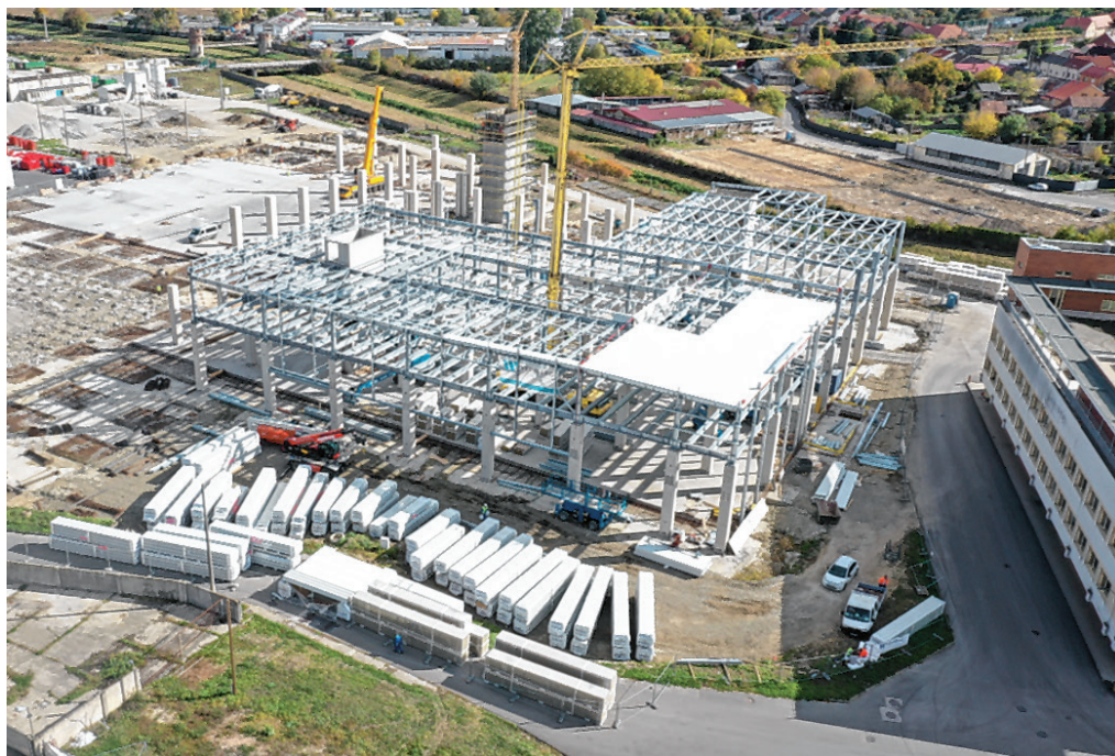
Az acélszerkezet szerelése és a tetőpanel telepítése zajlik
